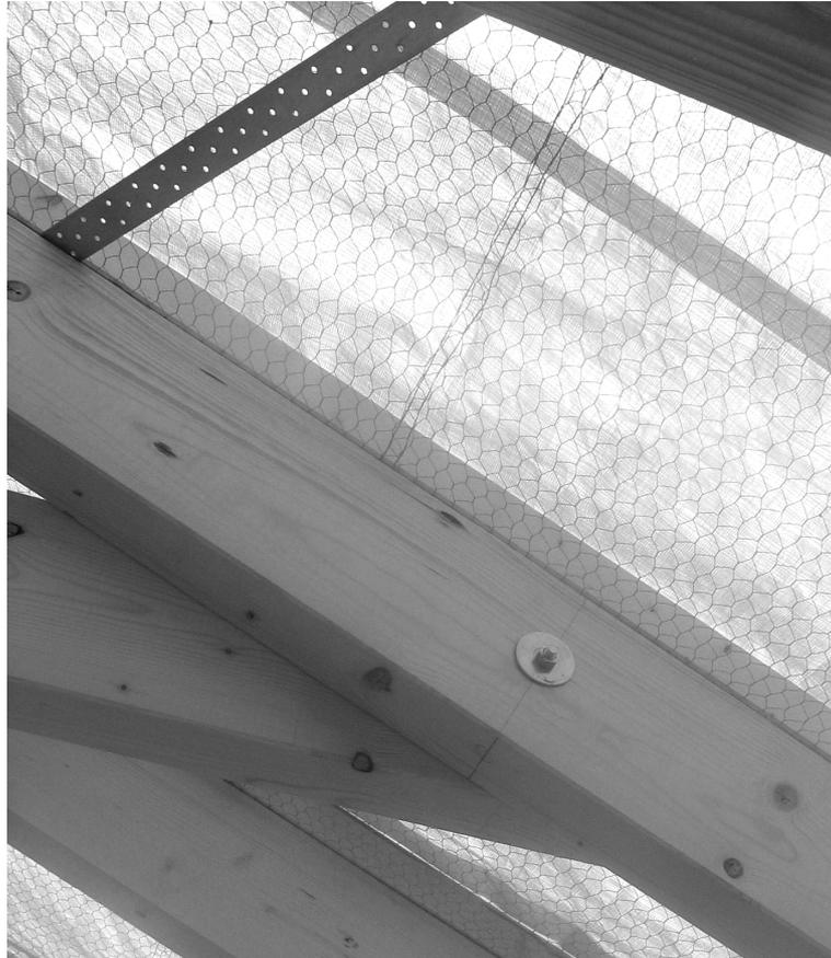
Abb. 9: Korrosionsbeständiges Drahtgewebe über den Sparren und Sparrenzwischenräumen.
