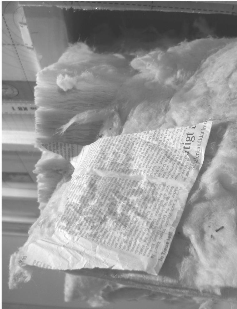
Abb. 5: Eis und (mit Zeitungspapier sichtbar gemachte) Nässe auf (und in) der Wärmedämmschicht über einer (luft-)undichten „*Feuchteadaptiven Dampfbremse*“ in einer nicht belüfteten (Dach-)Konstruktion.
