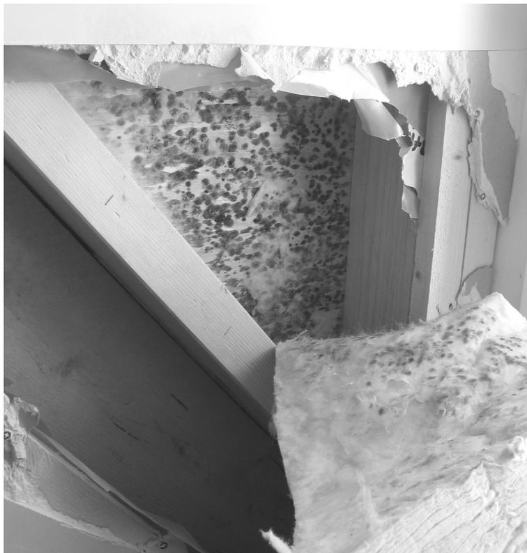
Abb. 2: Blick (von innen) auf Wärmedämmschicht und Holzwerkstoffplatte in der außen mit Blech bekleideten Seitenfläche der Dachgaube
