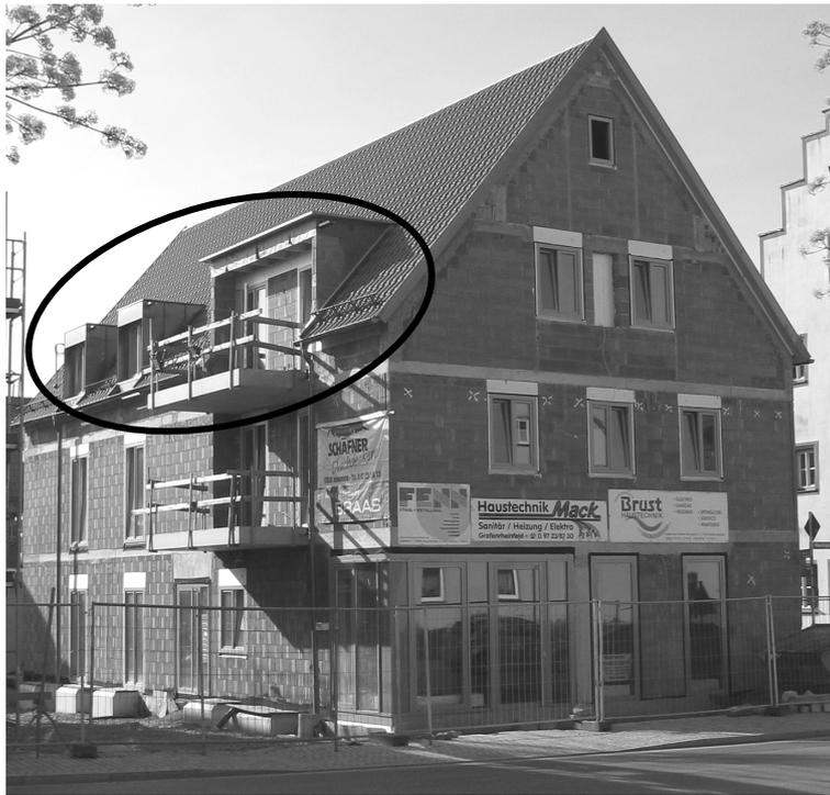
Abb. 1: Außen mit Blech bekleidete Dachgauben
