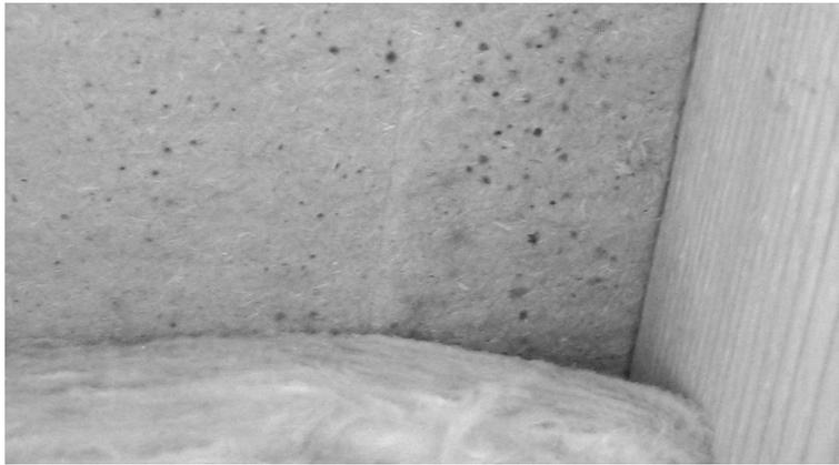
Abb. 6: Nasse und (schimmelpilzartig) verfärbte Unterdeckplatte
