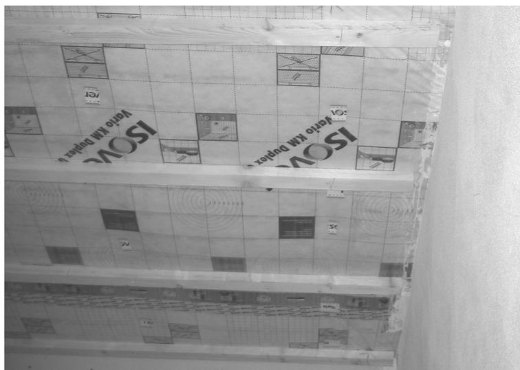
Abb. 4: „*Feuchteadaptive Dampfbremse*“ als Luftdichtschicht
